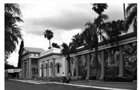
- Pórtico Cementerio La Piedad. Posadas. Fotografías: Arq. Alina Bistoletti. Año 2014. Archivo AM. - Pórtico cementerio de Corrientes. Fuente: http://www.tncorrientes.com/galeria/Cementerio-San-Juan-Bautista-de-Corrientes.jpg
